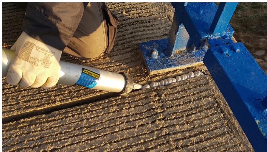
vyplňování spár nové betonáže
