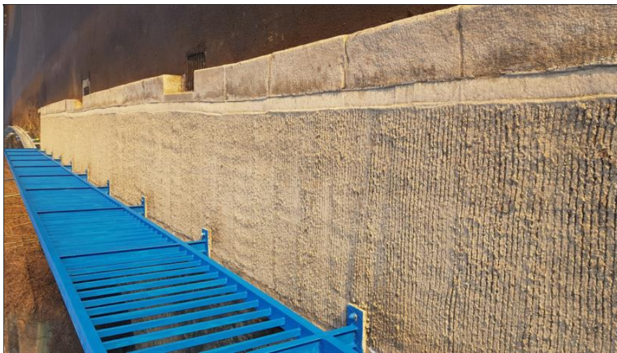
levý chodník s odvodněním
