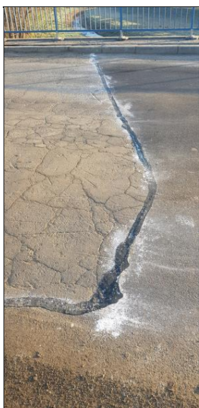
mozaikově rozpadlá vozovka před a za mostem
