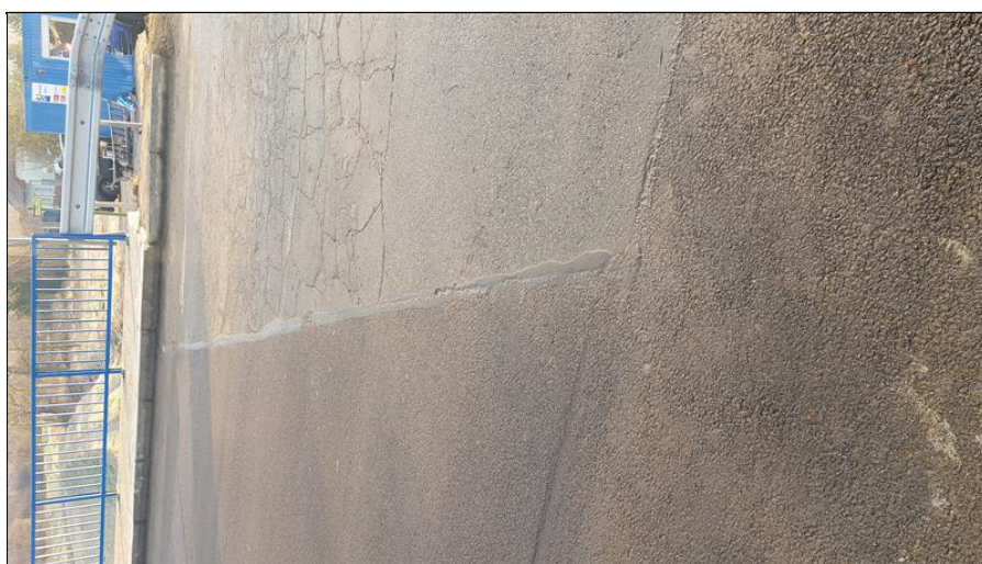
prořizlá a zalitá spára nad dilatací
