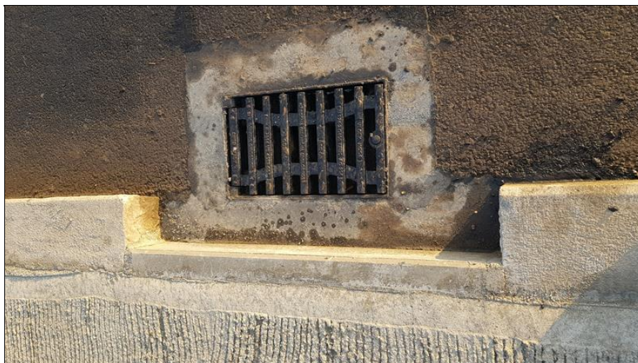
nové 4ks odvodňovačů
